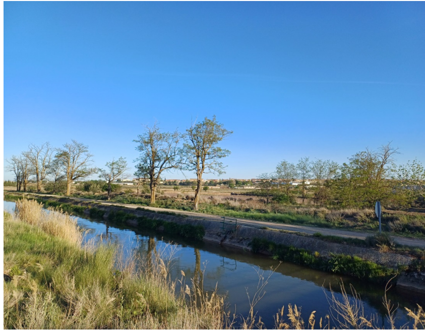
Vista del Canal de Lodosa en el límite del ámbito.
